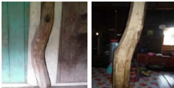
Gambar 4. Tiang Bengkok pada rumah gadang Kajang Padati (Sumber: Dokumentasi Refisrul)
