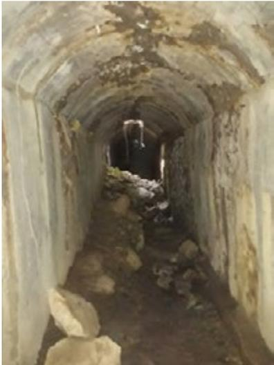
Gambar 2. Salah satu bangunan terowongan. Struktur pintu masuk ukurannya relatif kecil dan ketika memasuki bagian dalam ukurannya cukup luas. Jarak lokasi terowongan sekitar 1 km dari Kantor Desa Lintidu. (Sumber: Penulis, 2020)
