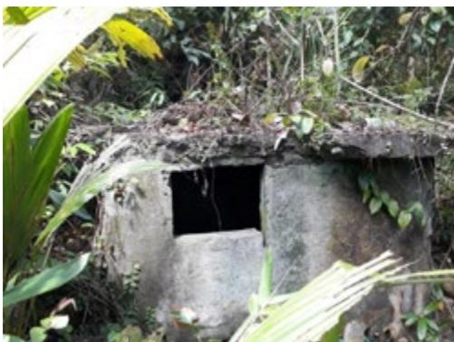
Gambar 3. Salah satu bangunan lubang sumuran tegak (*vertical shaft*). (Sumber: Penulis, 2020)
